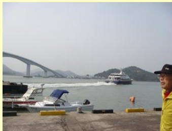
島間を結ぶ橋
