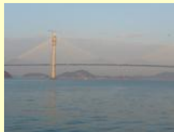
間もなく開通する木浦大橋
